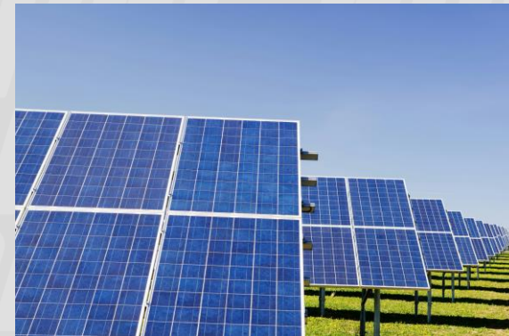
Installation de Panneaux Solaires
